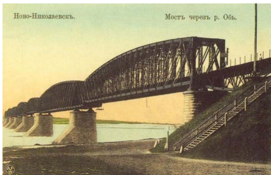
Мост в Ново-Николаевске
